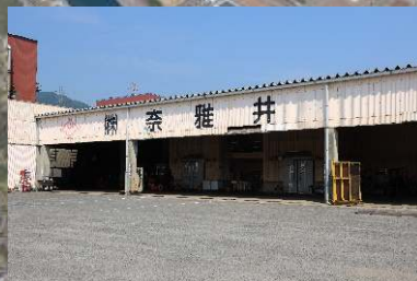
楠久地区倉庫
