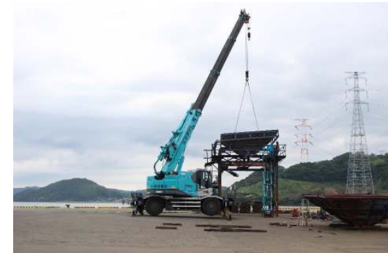
25T ラフタークレーン 1 台 例：吊り込み作業
