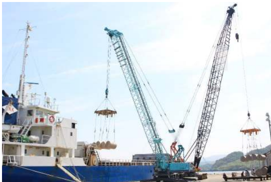
50T ラフタークレーン 1 台 例：ロール紙荷役
