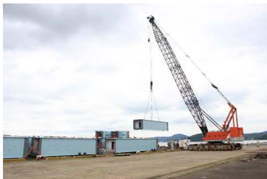
100Tクローラークレーン1台 例：橋桁荷役
