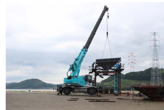
25Tラフタークレーン1台 例：吊り込み作業
