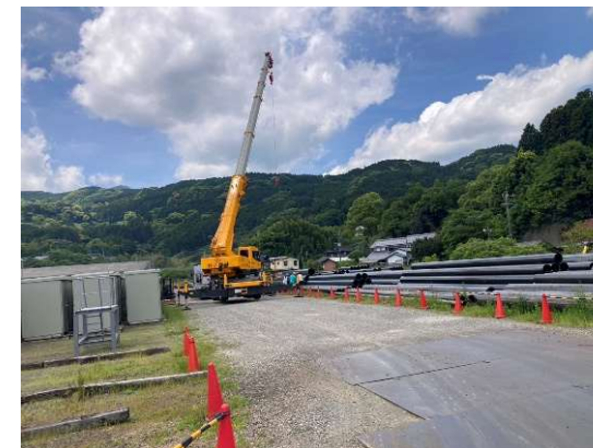
35Tラフタークレーン1台 例：吊り込み作業
